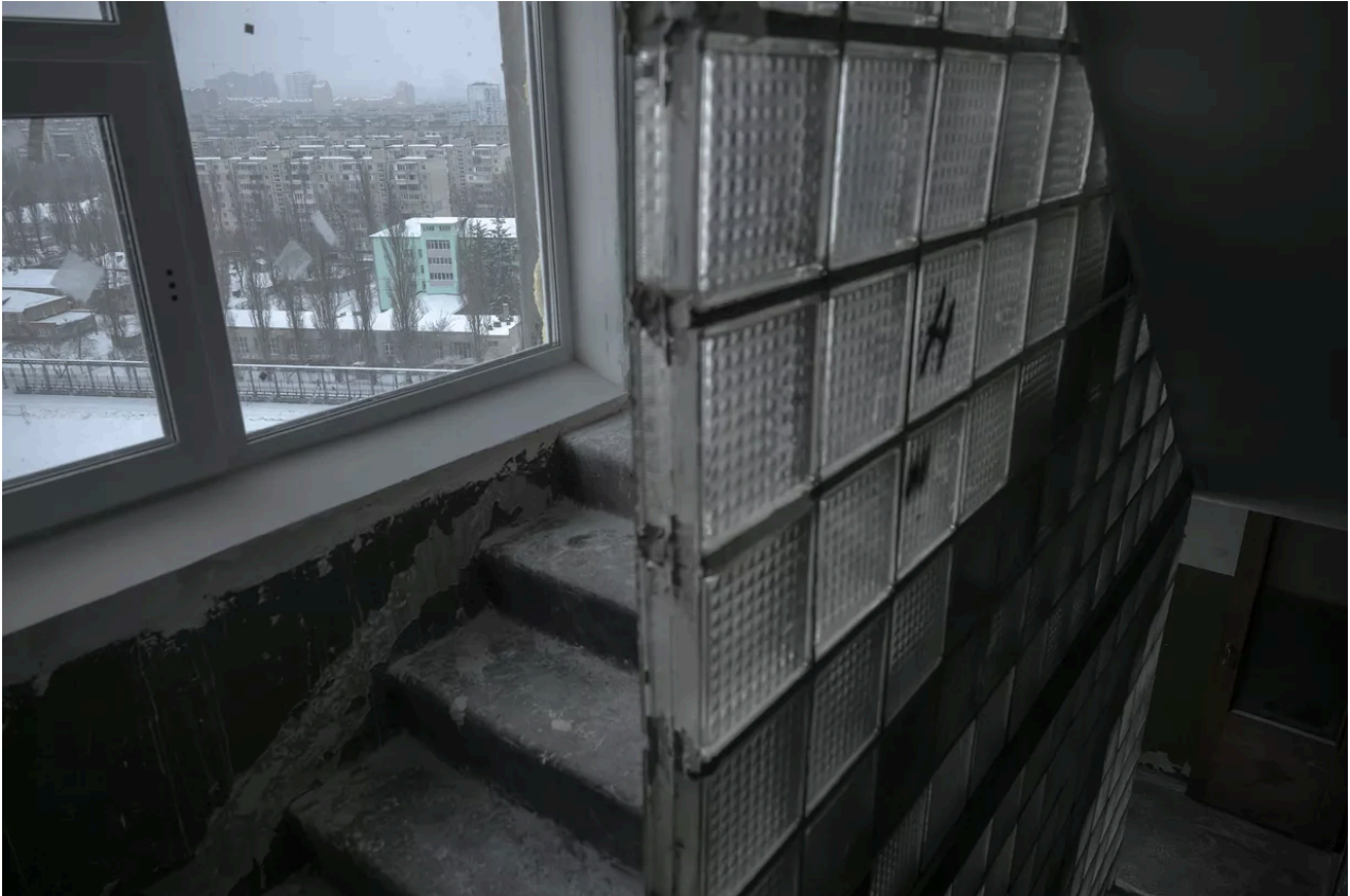
Escaliers menant au 15 e étage d'un immeuble datant des années 1970 au Shamon 14. Albert Lores pour Le Figaro
